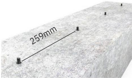
1. Bohren, absaugen, Kleber und Verbundanker einsetzen.
