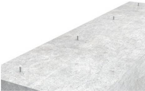
1. Bohren, absaugen, Kleber und Verbundanker einsetzen.
