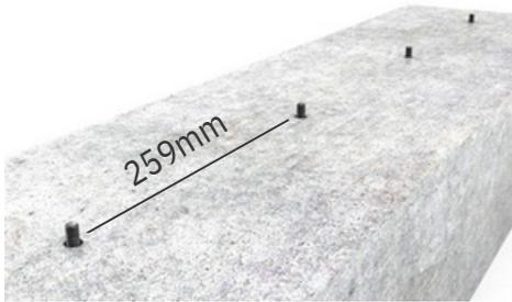
1. Bohren, absaugen, Kleber und Verbundanker einsetzen.
