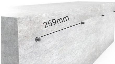
1. Bohren, absaugen, Kleber und Verbundanker einsetzen.
