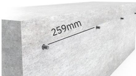
1. Bohren, absaugen, Kleber und Verbundanker einsetzen.
